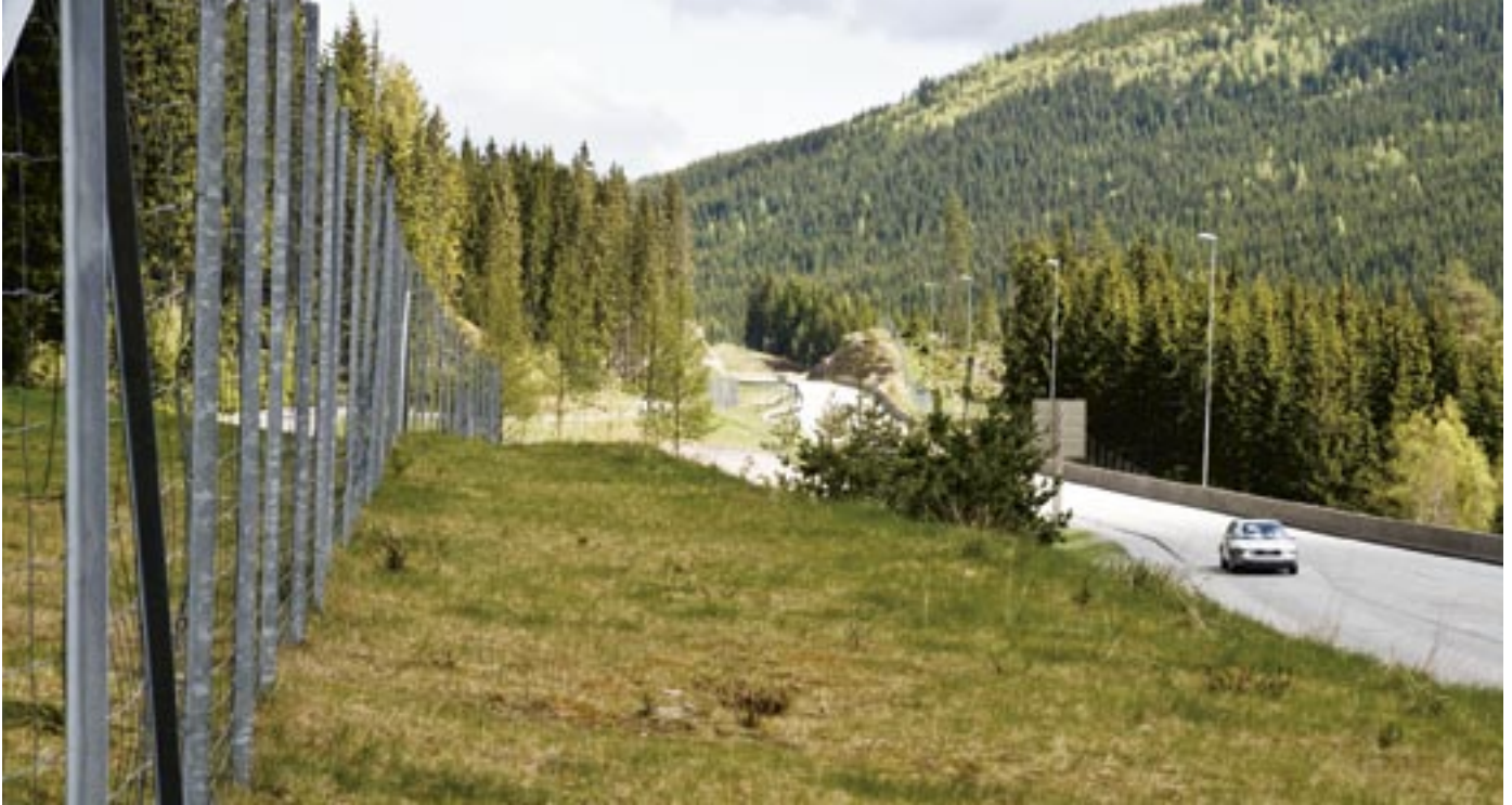
Viltgjerde langs R35. Foto: Per Fosshim.
