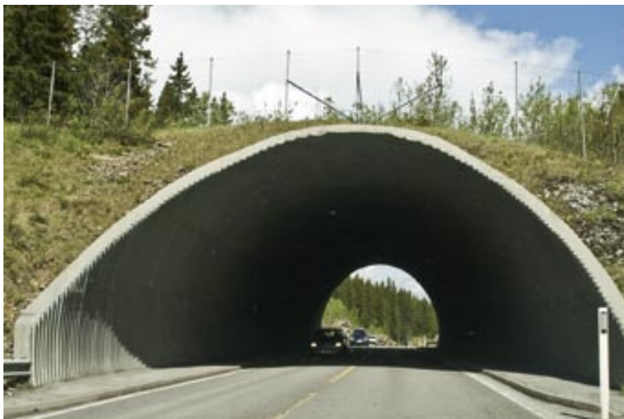
Faunapassasje på R35. Foto: Per Fossheim.
