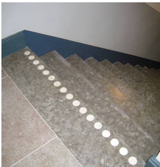
Figur 17. Trapp rehabilitert og øverste trinn markert av hensyn til universell utforming
